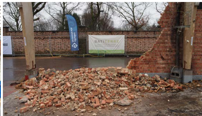
Briques réutilisées dans le cadre du développement du projet Stevin à 1080 Molenbeek-Saint-Jean
