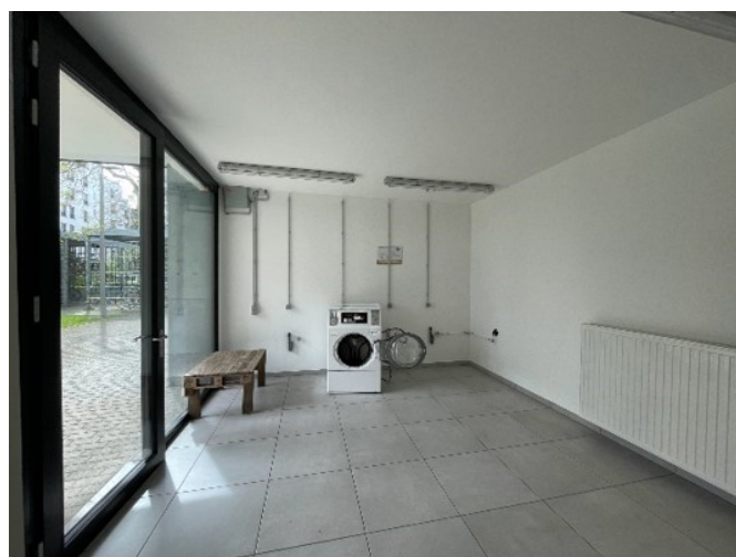
Wasruimte huizenblok 2: afgekoppelde wasmachine
