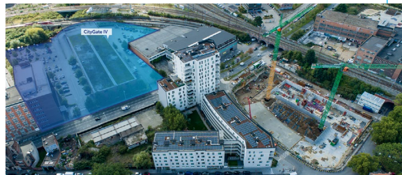
Rue des Deux Gares 84, 1070 Anderlecht
